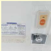
ラップフィルムによる養生（汚染防止）
